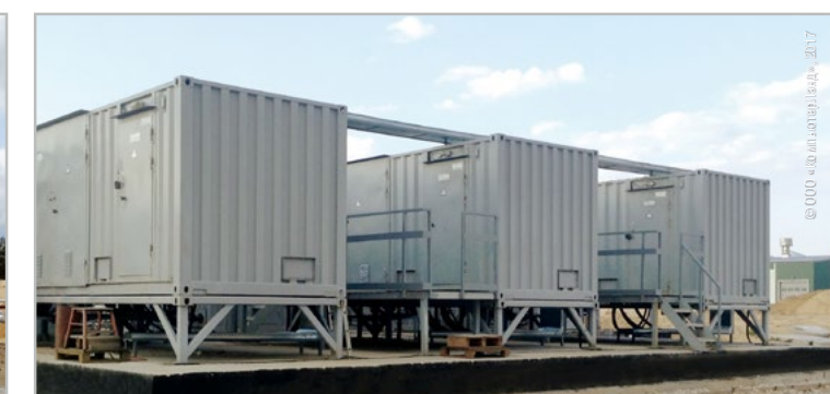
Блок-модули ктп 2500 кВа 0,4/10 кВ
