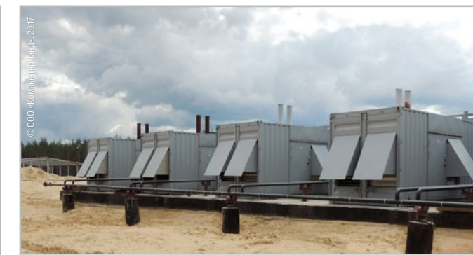
Блок-модули ДГУ 1000 кВт
