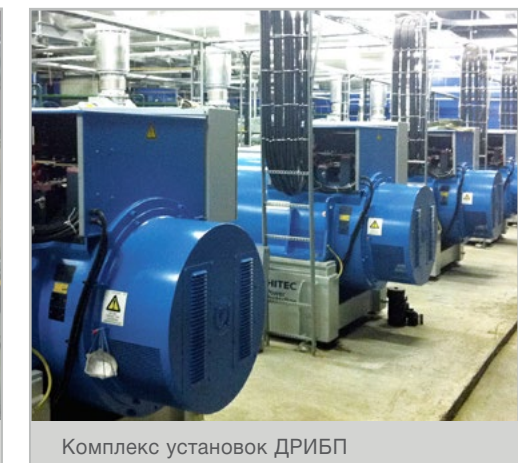
Блок-модули ДГУ 1000 кВт
