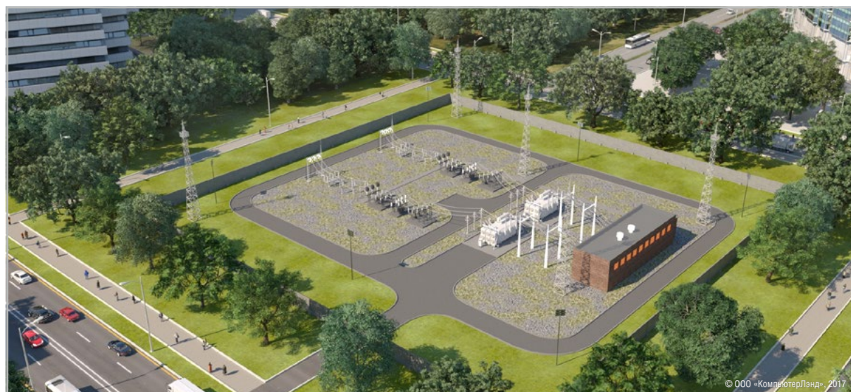
Подстанция с применением ОРУ 110 кВ
