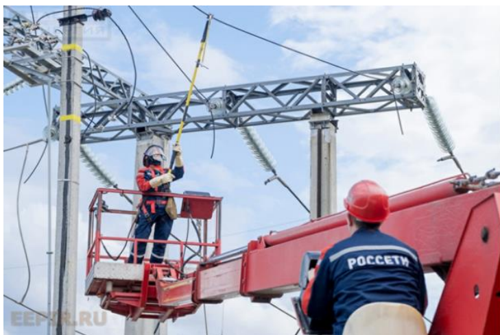
Рис. 16 Безопасное выполнение работ на автогидроподъемнике с применением двух удерживающих стропов
