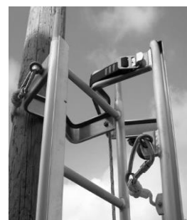
Рис. 8 Расположение соединительной секции перед началом монтажа
