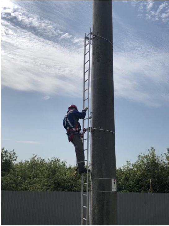
Рис. 10 Монтаж лестницы с единовременным подъемом на опору ПБ-500
