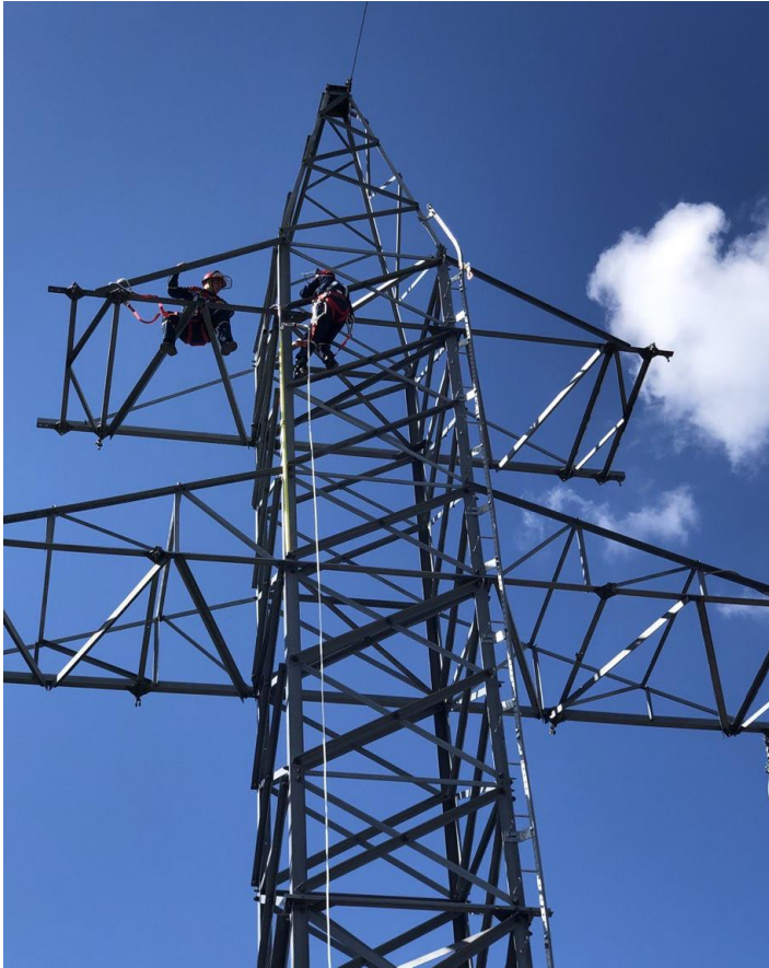
Рис. 15 Работы на траверсе ВЛ 110 кВ
