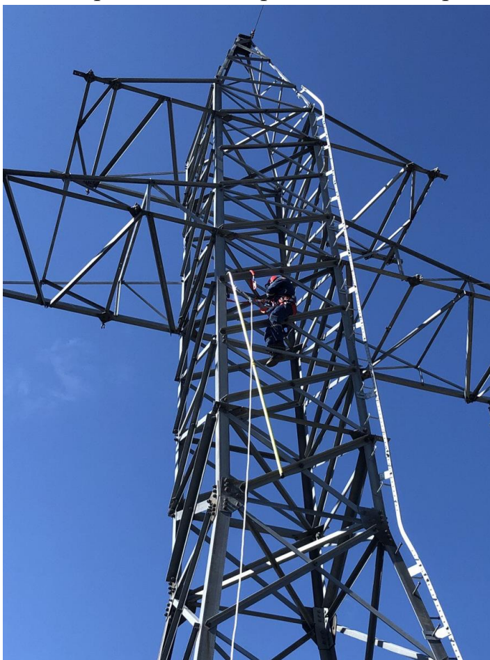
Рис. 6 Создание гибкой анкерной линии с применением временного переносного анкерного устройства (стекловолоконной анкерной штанги)
