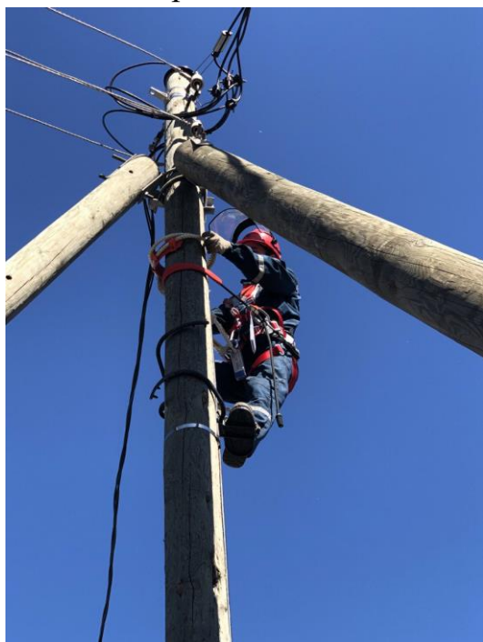
Рис. 1 Подъем на опору с применением переносного анкерного устройства
