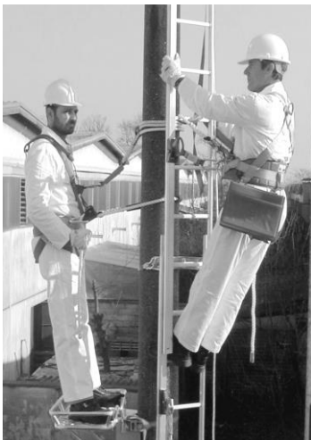
Рис. 11 Смонтированная сервисная платформа
